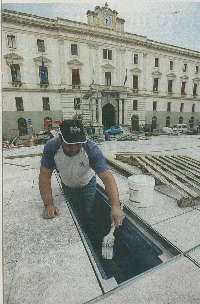
RITOCCHI Interventi per sistemare tubazioni e quant'altro al di sotto della nuova pavimentazione [foto Tony Vecce]
